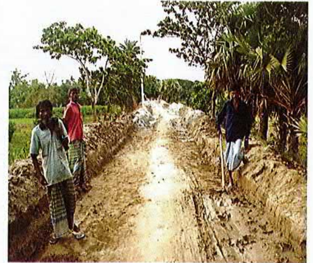
চিত্র ২-১৯: সাবগ্রেড নির্মাণ কাজ
