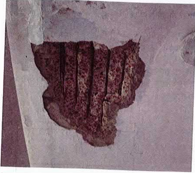
চিত্র ৮- ৬ঃ ছাদের রডে মরিচা পড়ে প্রাষ্টার ও কংক্রিট ফসে পড়েছে
