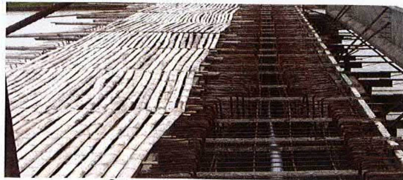
চিত্র ৭-৮ঃ রডের উপর কাঠের তক্তা
