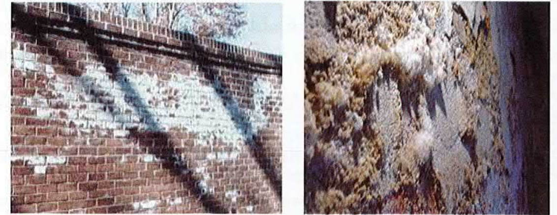
চিত্র ৮- ৮ঃ নোনা পড়ে ক্ষতিগ্রস্ত ওয়াল
