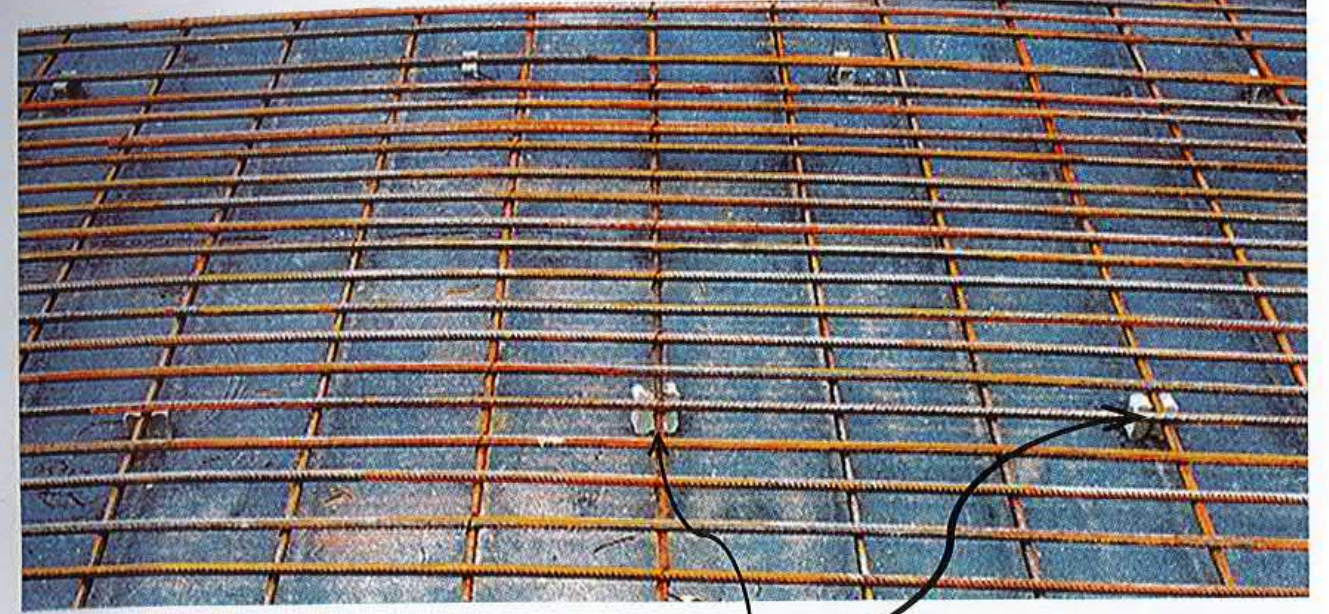
স্ল্যাবের রডে ক্রিয়ার কভার হিসেবে মর্টার ব্লক তার দিয়ে বেঁধে দেয়া হয়েছে এবং সর্বনিম্ন রডের (bottom layer) নিচে দেয়া হয়েছে চিত্র ৭- ১২ঃ বীম ও স্ল্যাবে ক্রিয়ার কভার মর্টার ব্লক স্থাপন
